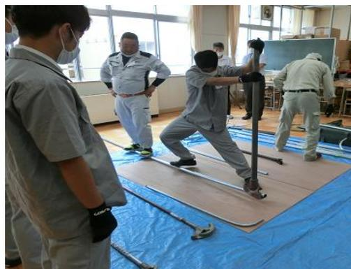
厚鋼電線管 G22 曲げ作業②
