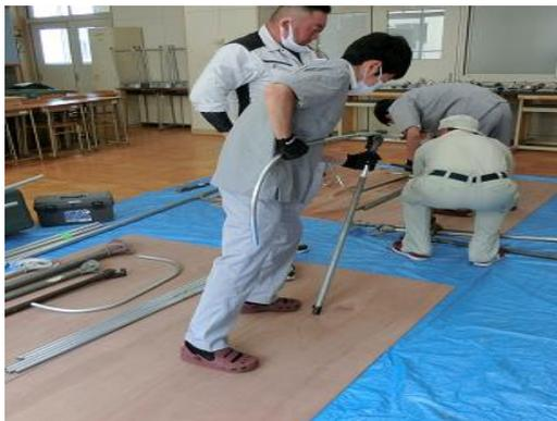
薄鋼電線管 E19 曲げ作業①
