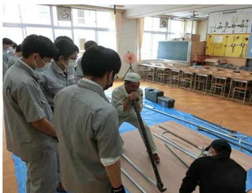
厚鋼電線管 E25 曲げ作業③
